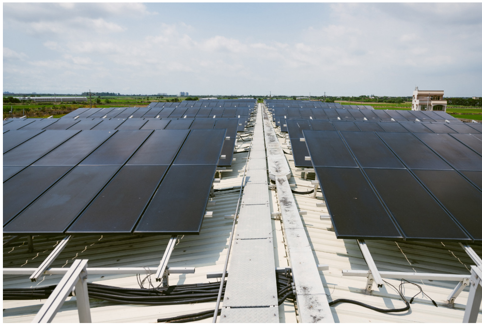
2017年御正食品取得「綠農場」標章，完成於雞舍屋頂搭載太陽能光電板，室內安裝節能燈具等措施。
